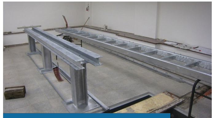
Aufbau von Tragkonstruktion der Rinne
