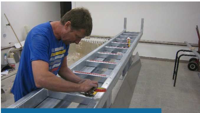
Verklebungsvorbereitung der rostfreien Sohle der Rinne
